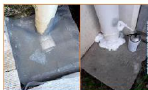
Tulle moustiquaire, mousse expansive ou joint sur regard de descente d'eau pluviale
