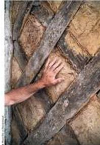
Historiquement, le torchis remplit une ossature en bois. Plusieurs variantes existent notamment celle du bambou, espèce végétale à croissance rapide et résistance mécanique forte.
