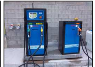
Benne à ordure ménagère de la CAGV roulant à 100% HVP et Système de distribution automatique installé sur site de VGA pour approvisionnement des véhicules.
